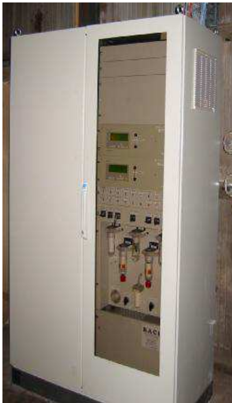
Slika 41. Automatska merna stanica koncentracijonih nivoa zagađenja vazduha
